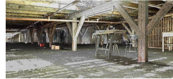
Beispiel: Punktwolke mit 73 Mio. Datenpunkten eines denkmal- geschützten Dachstuhls einer Spinnerei
